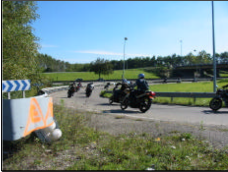
Glissières de sécurité accidentées depuis de nombreux mois Photo Gilles
