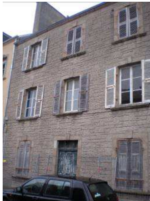
Façade avant travaux
