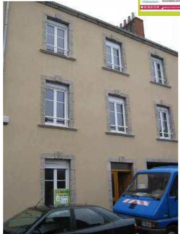
Façade en cours de travaux
