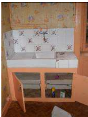
Éléments de confort existants avant travaux
