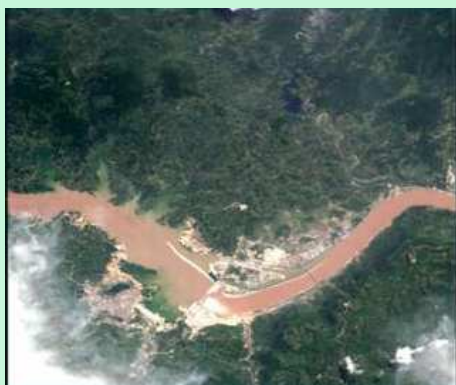
Barrage des Trois-Gorges - Chine
