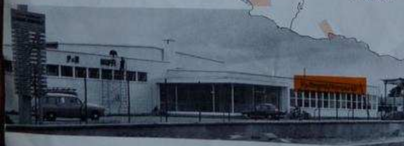
— Derniers travaux sur les nouveaux bâtiments de la société bordelaise.
