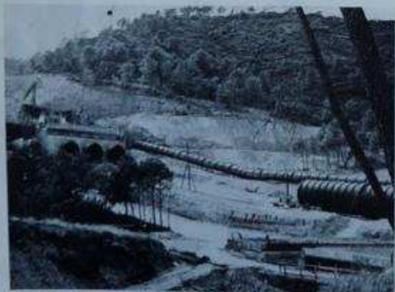
Aménagement hydroélectrique de St-Estève-Salern.
