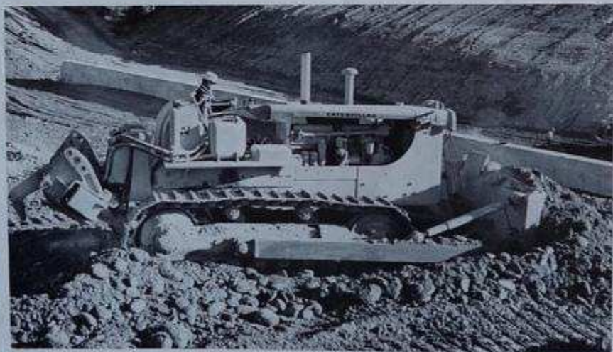
Un D 8 Caterpillar équipé en bulldozer et ripper à Orissa.
