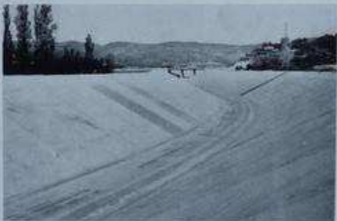
Le canal de fuite de la chute de Jougne, avant sa mise en eau.
