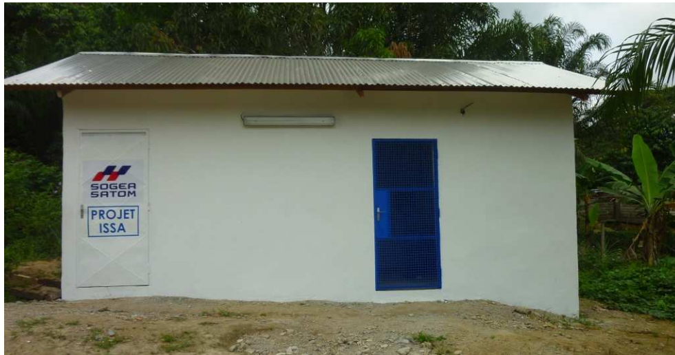
Local SATOM à l'entrée de la ferme à PK29
