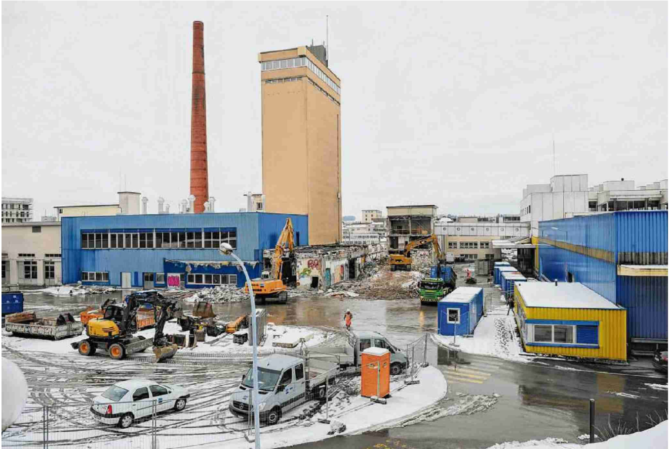
Die Abbrucharbeiten auf dem ehemaligen Cardinal-Areal in der Stadt Freiburg sind in vollem Gange.
