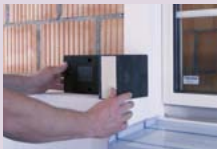
Photo 8 Intégration de l'élément de fixation de gonds à rupture de pont thermique.
