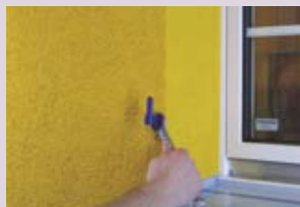
Photo 10 Vissage du gond du volet.
