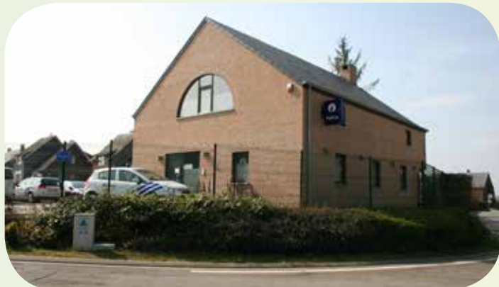
Zone de Police des Arches - Poste d'Assesse
