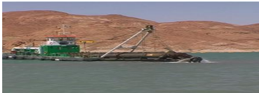
Photo 6: Drague activant dans la retenue du barrage Foum-El-Gherza (Biskra)
