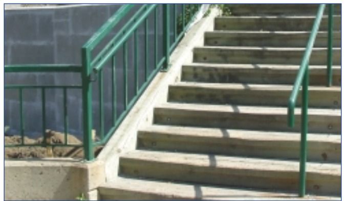
Mains-courantes et garde-corps extérieurs
