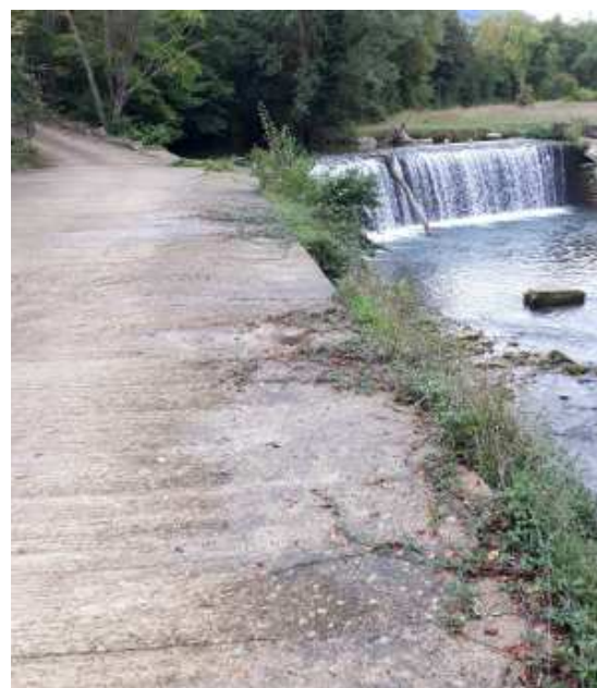
Fig. 6 - C GAUFFRE - 24/09/2020 - Appui bétonné à rafistoler
