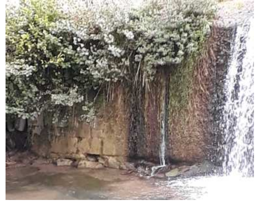
Fig. 3 - C GAUFFRE - 24/09/2020 La Chaussée : Un ouvrage exceptionnel
